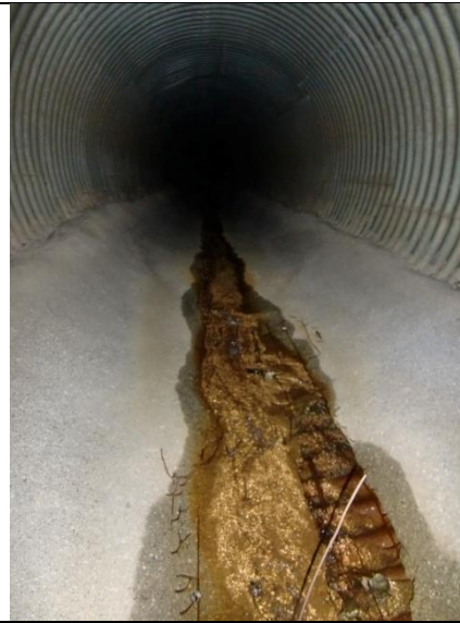
DESGASTE DE LA LOSA DE HORMIGÓN DE REFUERZO EXISTENTE
