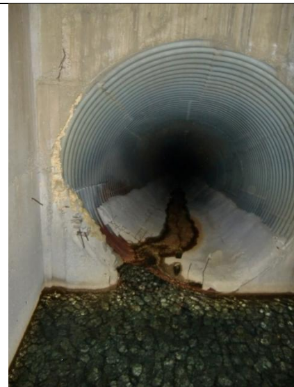
ZONAS A SELLAR DE LA ARQUETA 2 PARA EVITAR PÉRDIDAS DE AGUA EXISTENTES EN LA ACTUALIDAD
