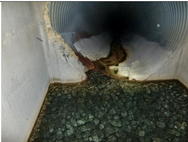
ZONAS A SELLAR DE LA ARQUETA 2 PARA EVITAR PÉRDIDAS DE AGUA EXISTENTES EN LA ACTUALIDAD
