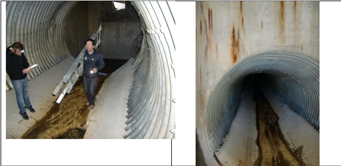
ESTADO DE CANALIZACIÓN
