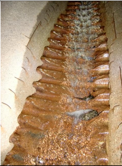
DESGASTE DE LA LOSA DE HORMIGÓN DE REFUERZO EXISTENTE
