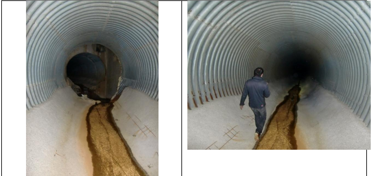
EN GENERAL TUBO CORRUGADO DE ACERO EN BUEN ESTADO
