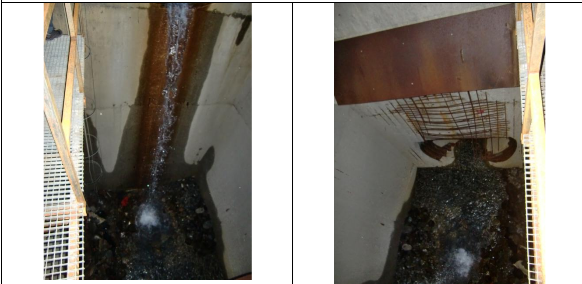
ESTADO DE ARQUETA
