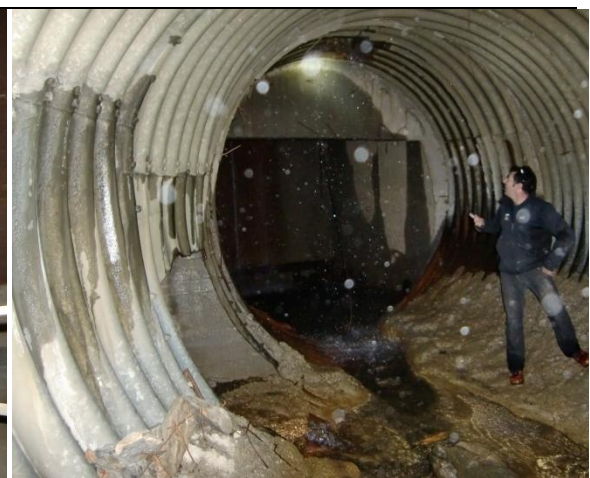
ARQUETA 8 FINAL TRAMO 7-8
