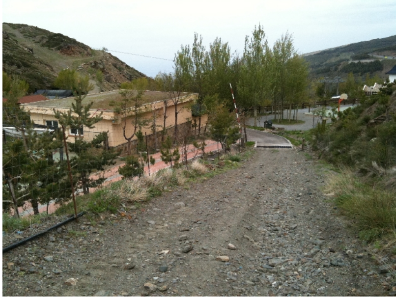
Ubicación de la caseta de bombeo
