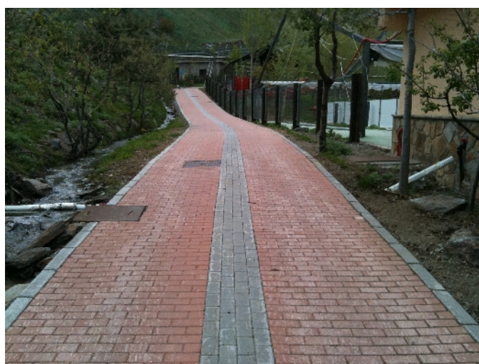
Salida tubería Caseta Área del Mirlo
